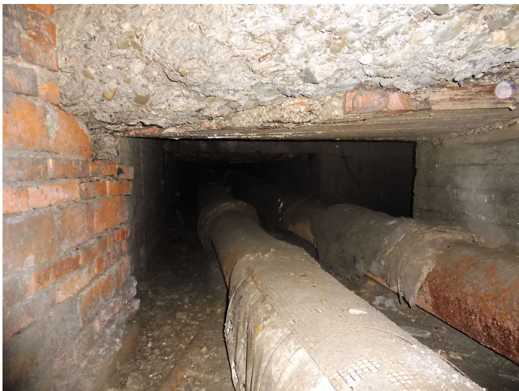
Obr.9- Teplovodní potrubí
